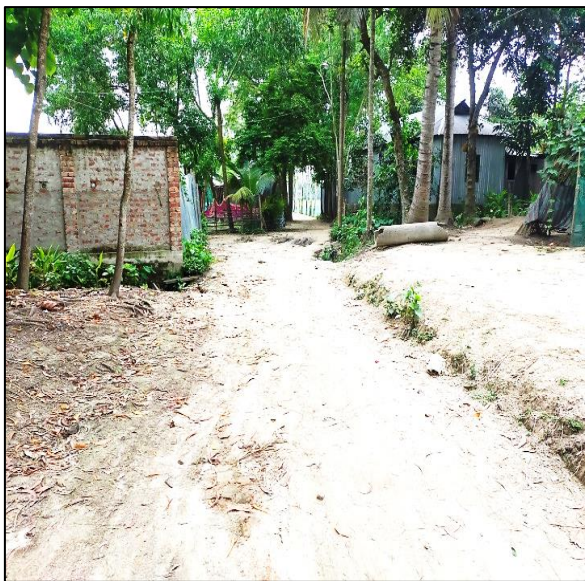
Road- 23-, Madhupur Pourashava
